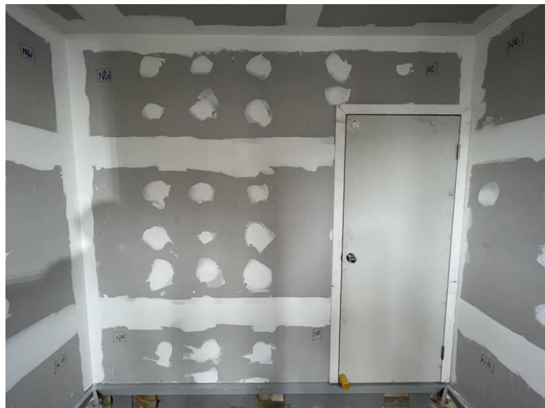
(d) After 1% ISD – internal
